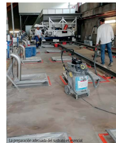
La preparación adecuada del sustrato es esencial
