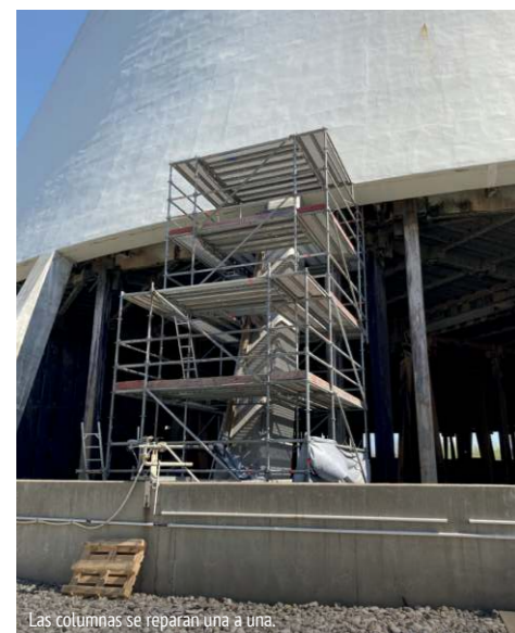
Las columnas se reparan una a una.
