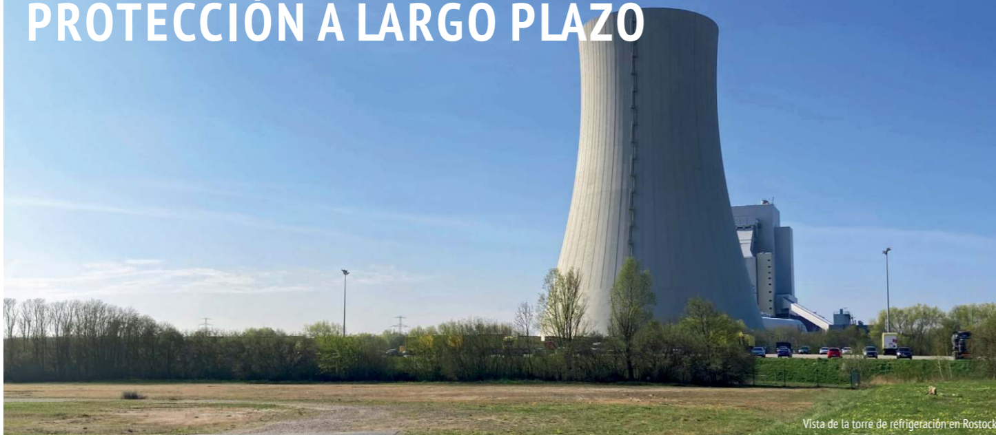
Vista de la torre de refrigeración en Rostock
