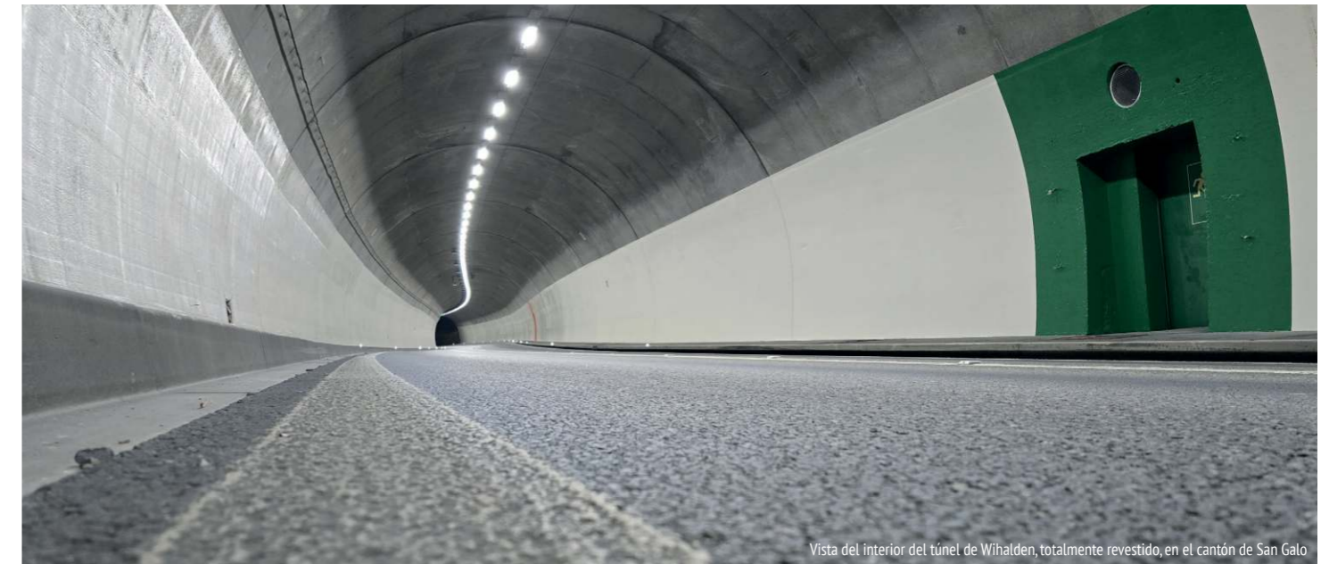
Vista del interior del túnel de Wihalden, totalmente revestido, en el cantón de San Galo
