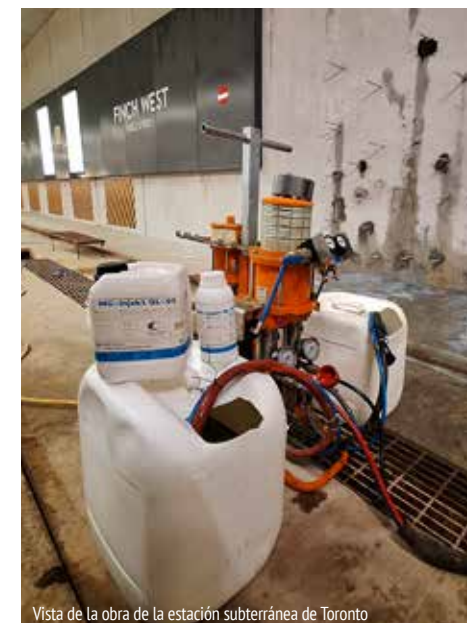
Vista de la obra de la estación subterránea de Toronto
