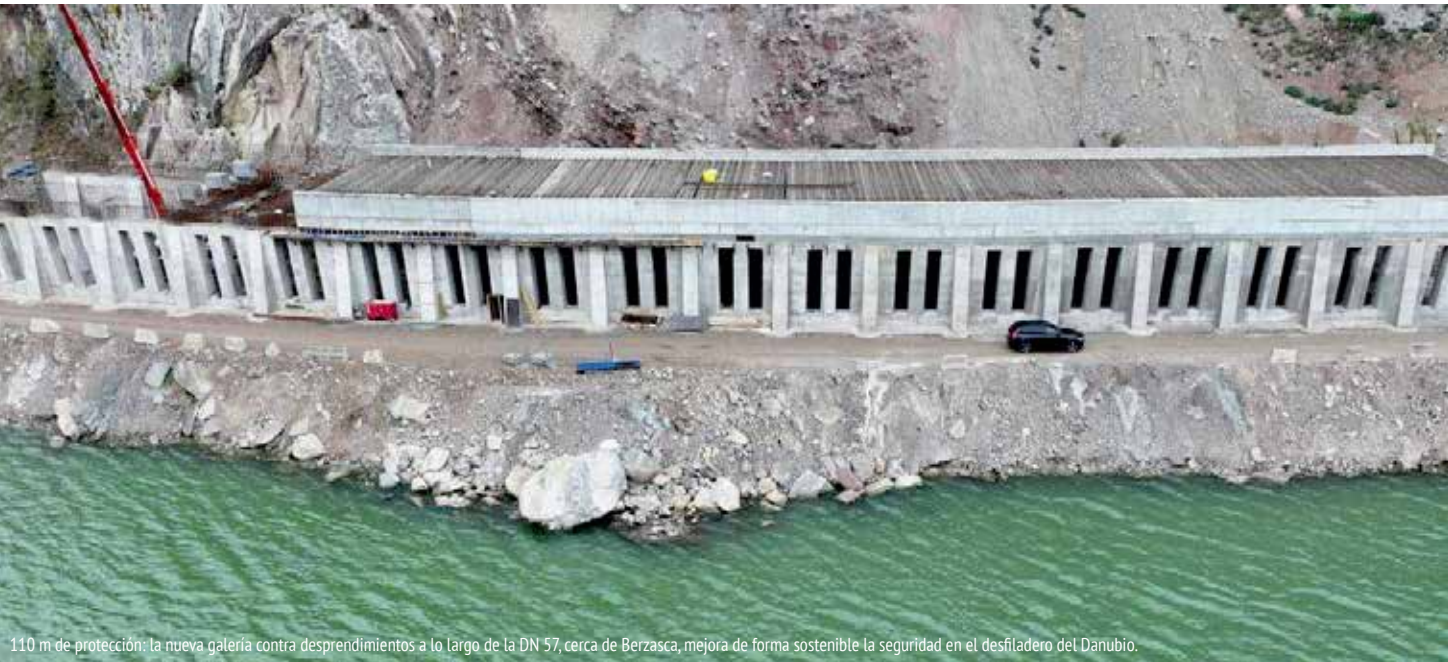
110 m de protección: la nueva galería contra desprendimientos a lo largo de la DN 57, cerca de Berzasca, mejora de forma sostenible la seguridad en el desfiladero del Danubio.
