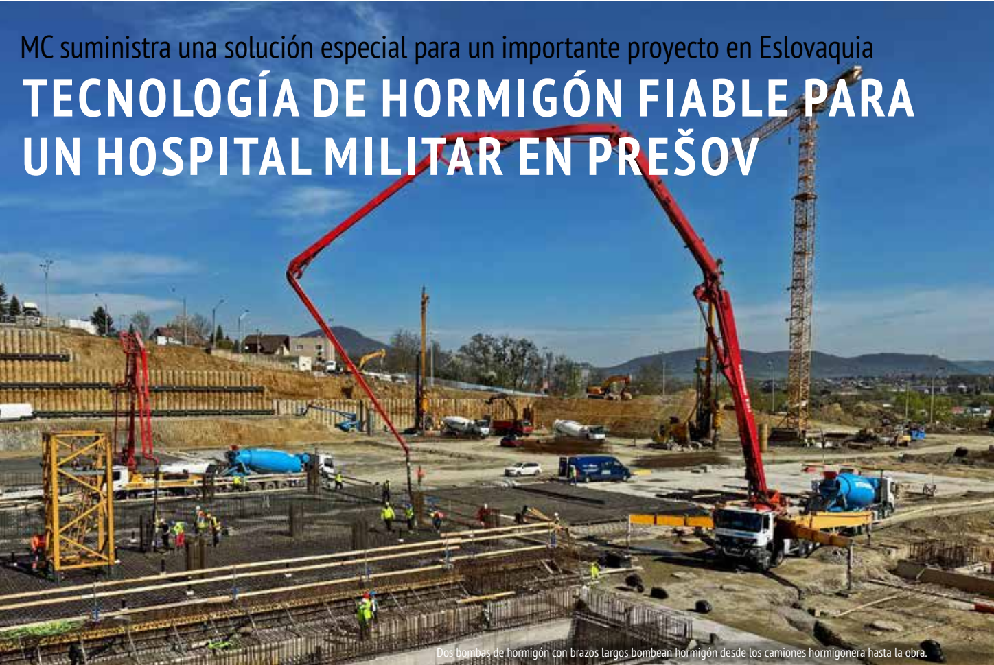
Dos bombas de hormigón con brazos largos bombean hormigón desde los camiones hormigonera hasta la obra.
