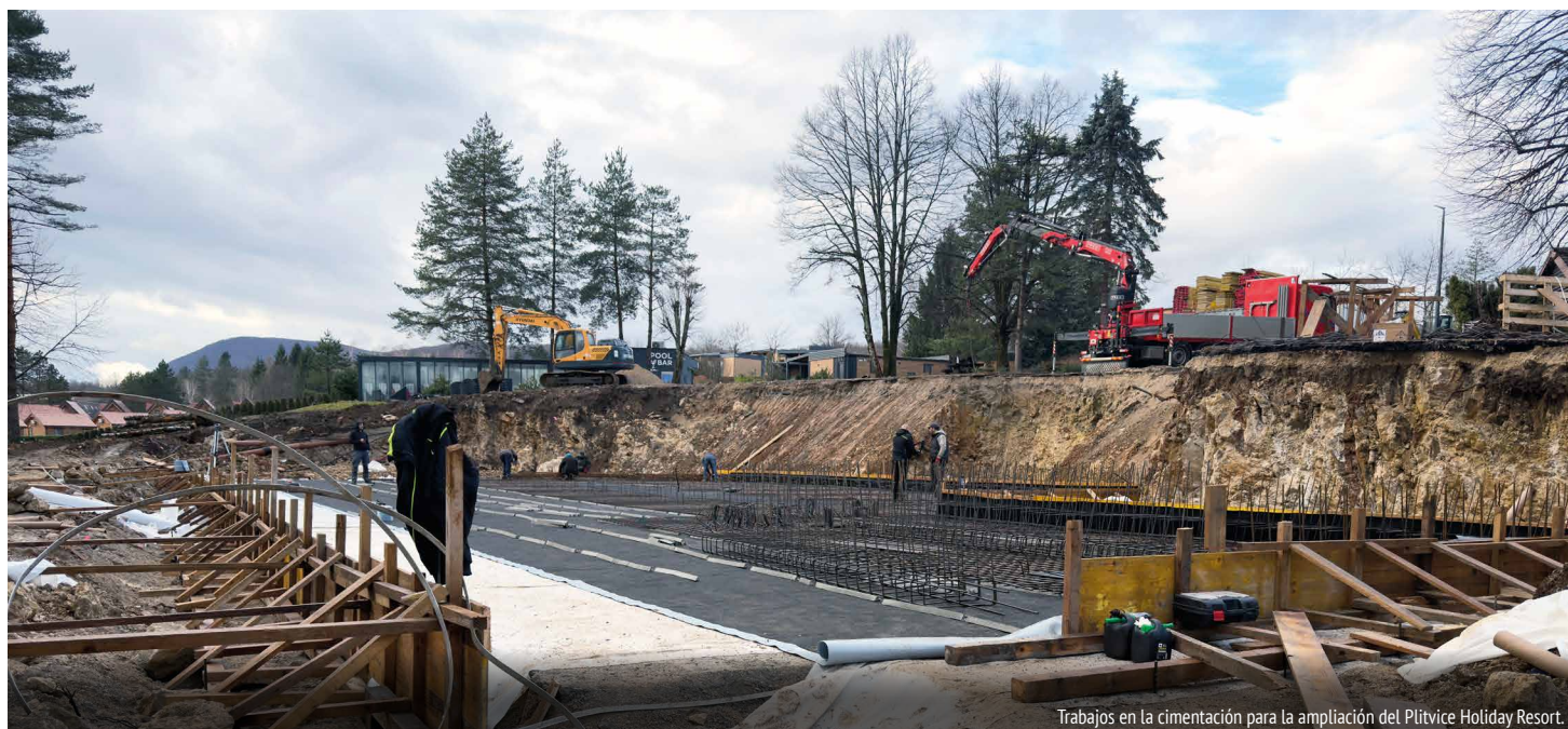
Trabajos en la cimentación para la ampliación del Plitvice Holiday Resort.
